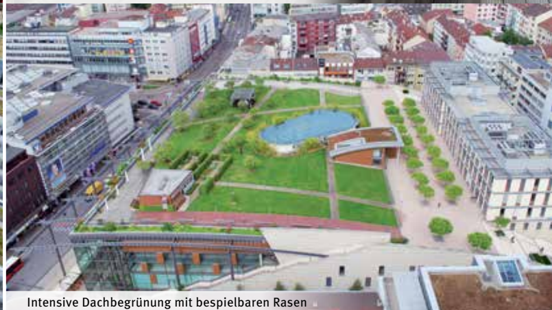
Intensive Dachbegrünung mit beispielbaren Rasen
